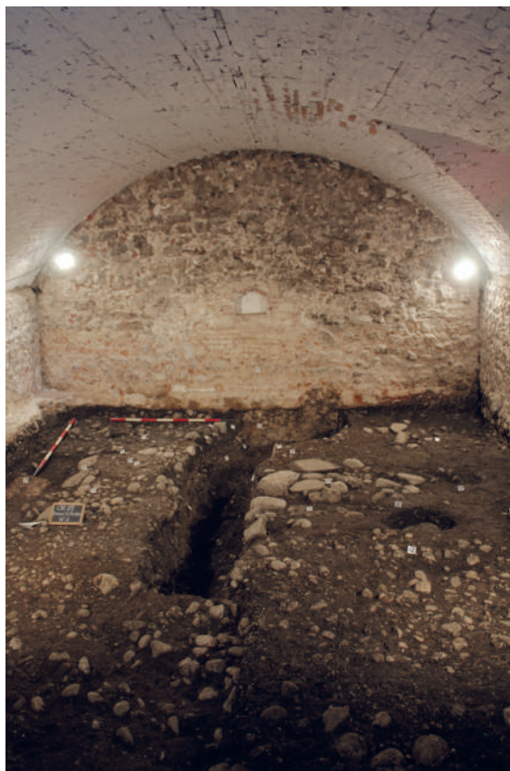
Fig. 4. Lo scavo nella cantina dell'edificio in Borgo S. Pietro 1: sul fondo il muraglione di cinta tardoantico (base) con la sua ricostruzione medievale, inglobato nell'edificio esistente.
