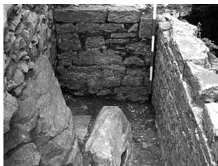
Fig. 5. La parete laterale meridionale.
