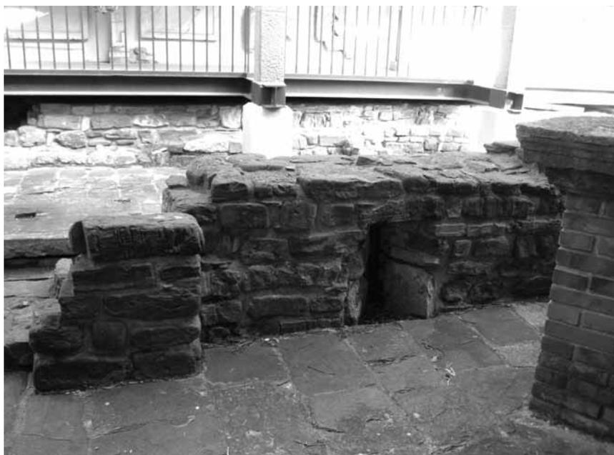
Fig. 14. Lapidario del Duomo: struttura muraria con feritoia strombata e lesena; in 2° piano è visibile un tratto del *castrum* est.
