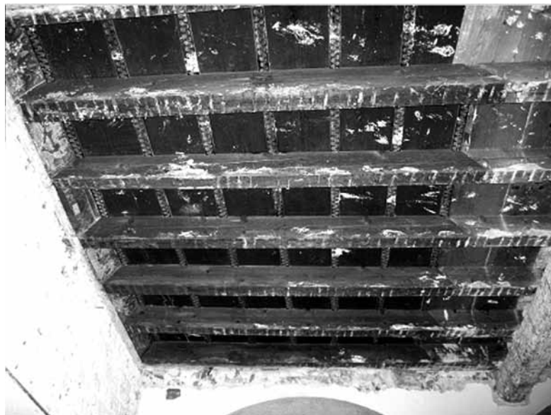
FIG. 8. Veduta d'insieme del solaio antico prima dell'intervento di restauro.
