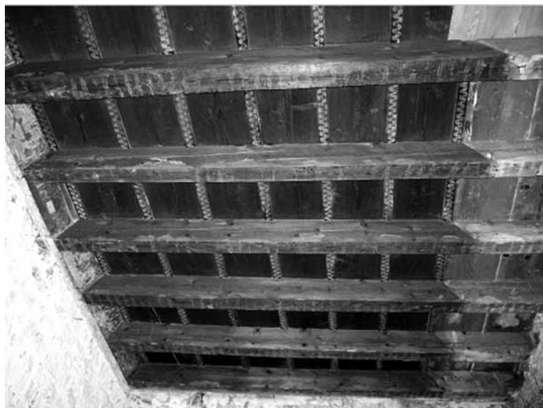
FIG. 9. Veduta d'insieme del solaio antico dopo l'intervento di restauro.
