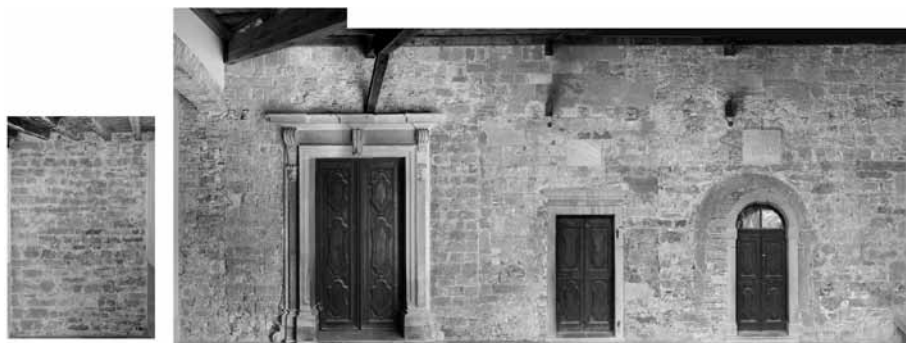
FIG. 5. Fotopiano della facciata del San Giovanni dopo la rimozione dello strato di intonaco.
