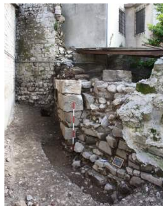
Fig. 11. Viale Libertà: intervento alle mura romane.
