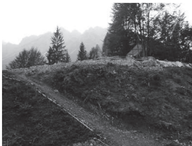
FIG. 2. Cuol di Ciastiel. Il paramento orientale del muro di cinta.
