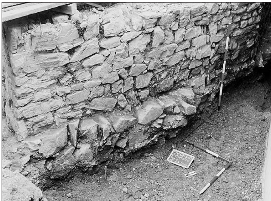
FIG. 6. La torre poligonale di Casa Canussio: particolare della risega e delle fondazioni.
